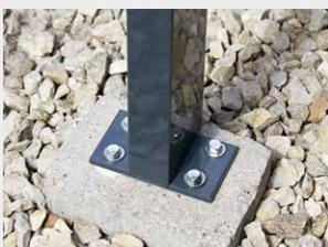
Poteaux avec trous de fixation prépercés
